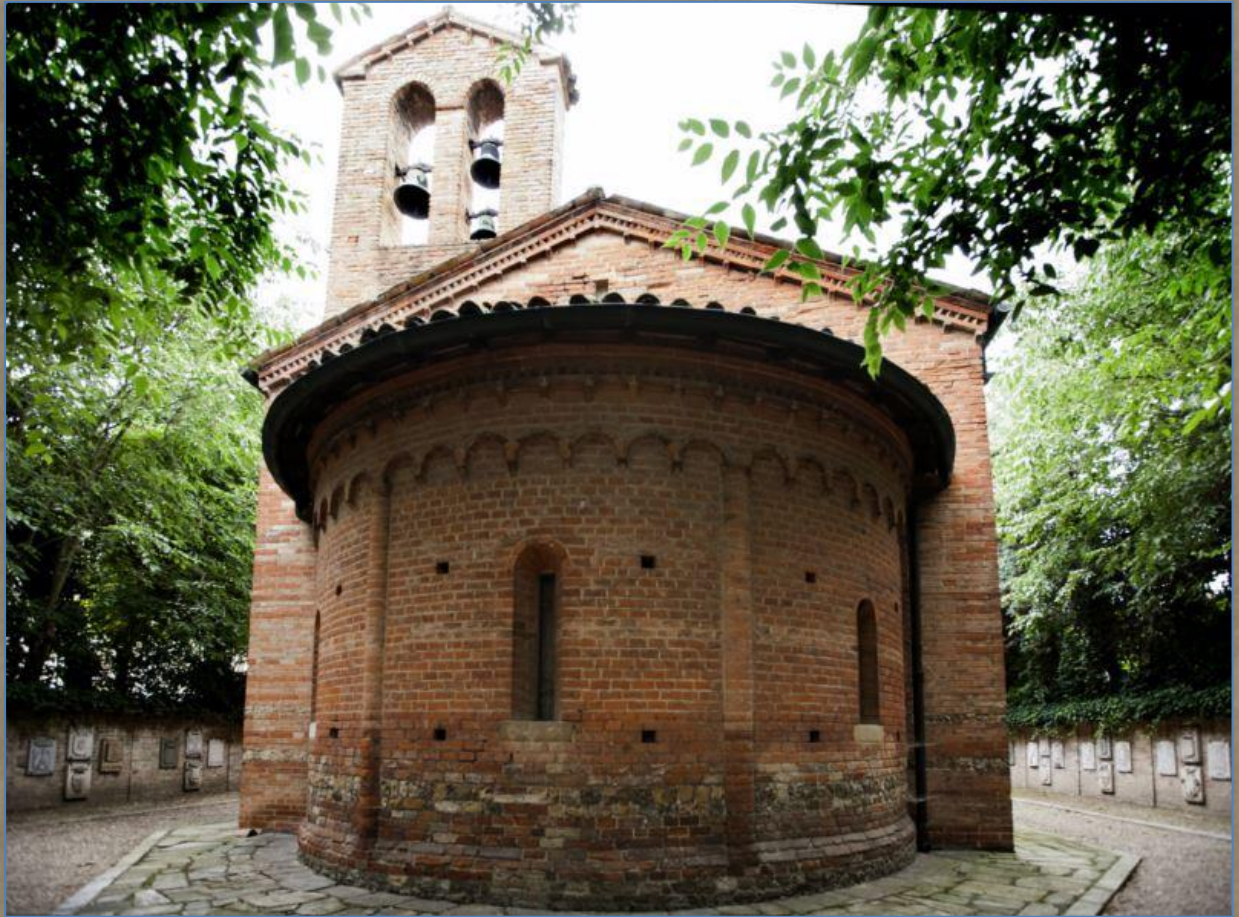
Abside del Tempio.
